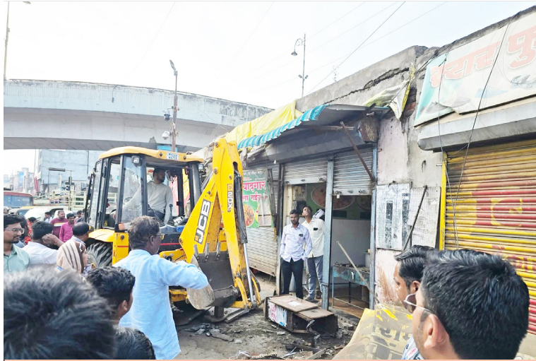
लातूर शहर महानगरपालिके अंतर्गत अतिक्रमणावर मोठी कारवाई... शहरात विविध पाच ठिकाणावरील अतिक्रमणावर बुलडोझर चालविण्यात येत आहे...
